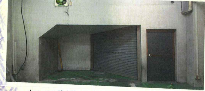
さて、この狭く低いスペースを如何に... 配管経路も含めて、頭をひねってプランニング。描いた図面に基づいて、職人さん頑張ります。...頭が当たりそうですけど(笑)
